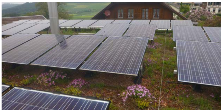
Figure 32 : Toit vert PV et système de sécurité à câbles, source : Contec
