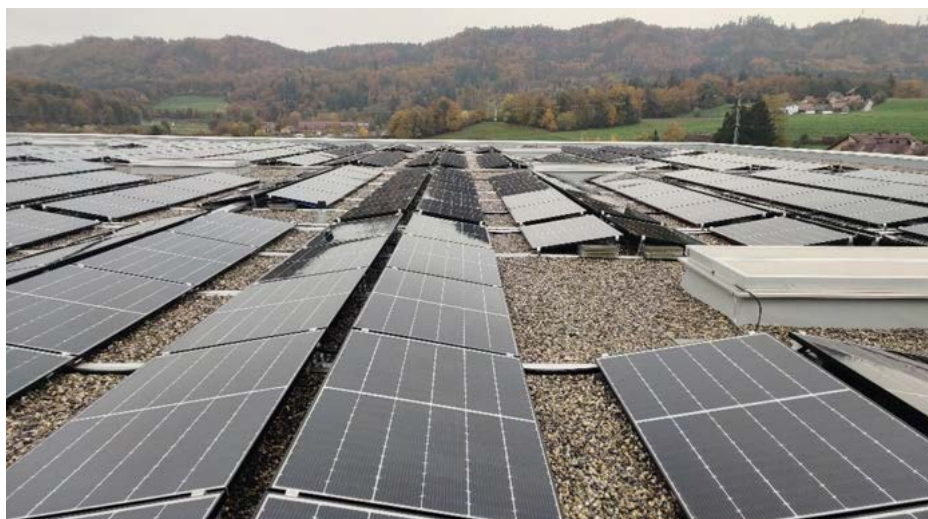
Figure 7 : Grande installation photovoltaïque avec voies d'accès pour l'entretien, source : Migros
