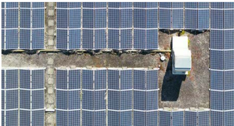
Figure 9 : Accès au système de ventilation assuré, source : Enveloppe des bâtiments Suisse
