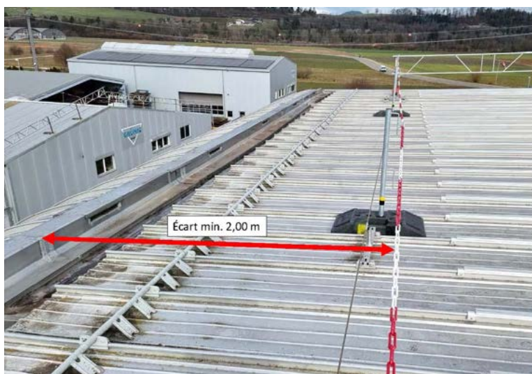
Figure 28 : Délimitation de zone avec une chaîne, source : Enveloppe des bâtiments Suisse
