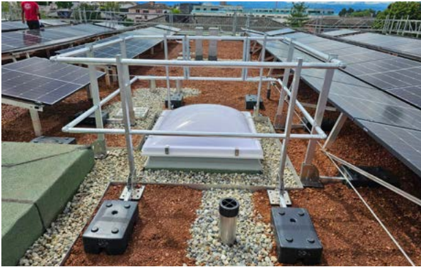
Figure 25 : Sécurité permanente pour coupole / lanterneaux avec garde-corps source : FPS Concept Sàrl
