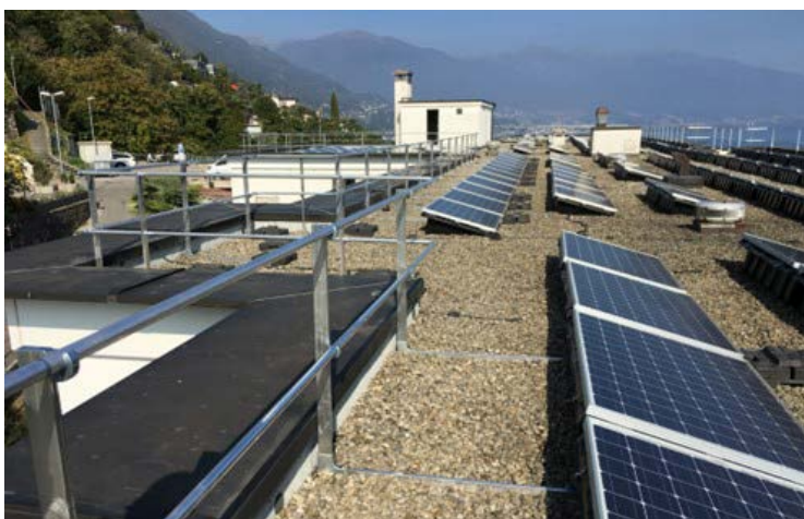
Figure 22 : Bord de toit sécurisé par un garde-corps permanent source : Gerry Wetterwald
