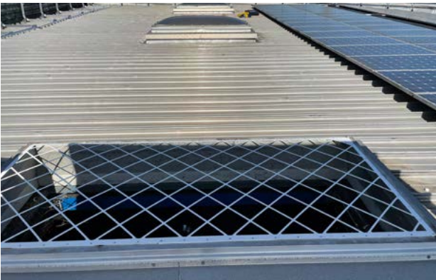
Figure 26 : Coupole avec sécurité sous la coque source : FPS Concept Sàrl
