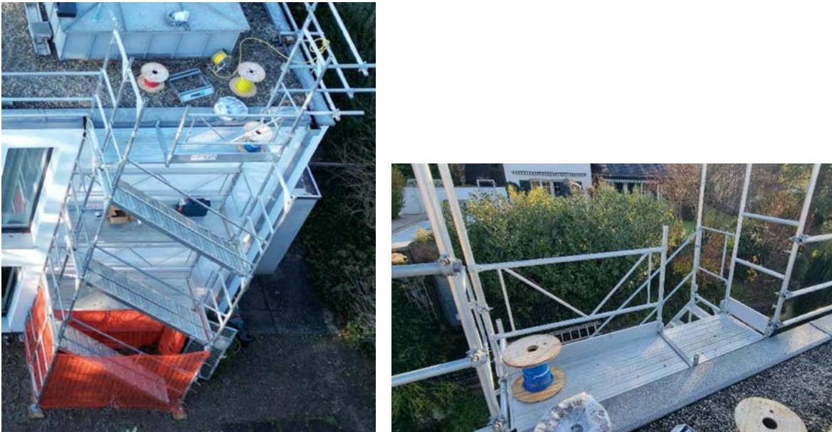
Figure 29 : Accès au poste de travail pour le montage PV au moyen d'une tour d'escalier, source : Enveloppe des bâtiments Suisse
