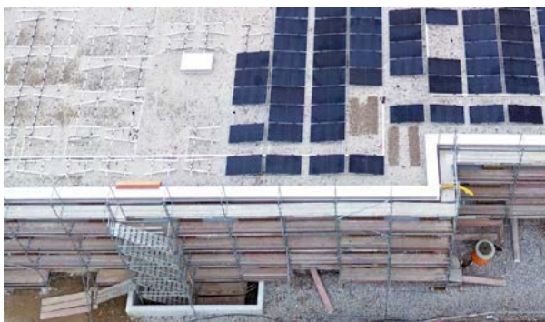
Figure 17 : Sécurisation du bord du toit au moyen d'un échafaudage de façade (classe de charge 3, 200 kg/m 2 ), largeur du pont d'échafaudage min. 60 cm, hauteur du garde-corps au-dessus du bord supérieur du toit min. 80 cm source : Enveloppe des bâtiments suisse
