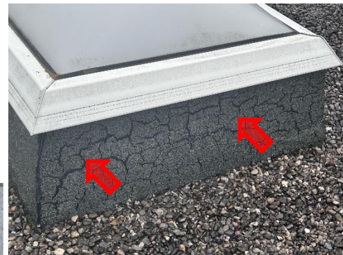
Fluage des relevés, l'étanchéité doit être reprise pour garantir une durée de vie en adéquation avec l'installation PV
