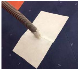
Étanchéité de la sous-couverture aux passages de câbles
