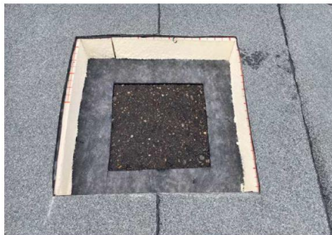
Sondage dans l'étanchéité afin de déterminer la qualité des couches
