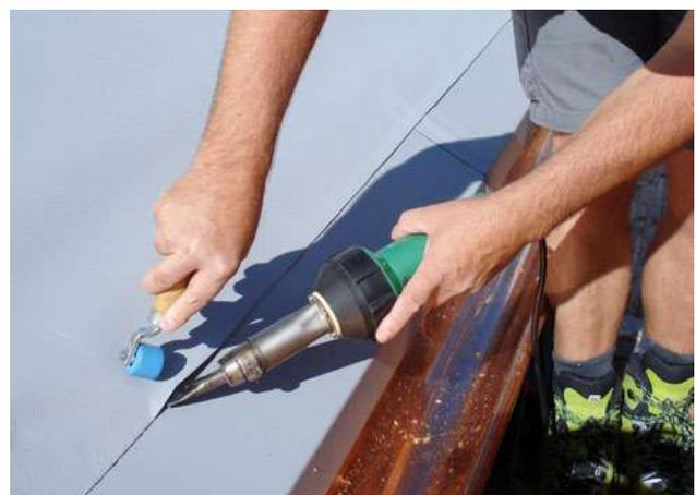
Illustration 13 : lé de sous-couverture sur bavette cachetée. Les joints proches de la bavette doivent être soudés.
