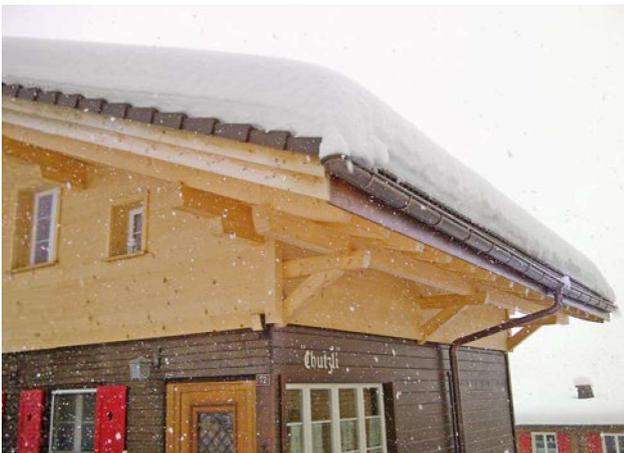
Illustration 16 : avant-toit isolé, presque pas d'eau de refoulement
