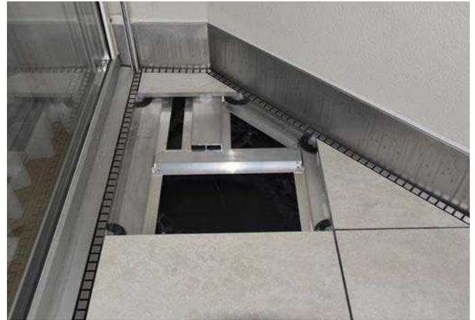
Fig. 20: les systèmes de rails servent à poser au mieux les revêtements en dalles de manière optimale et permettent de le faire de façon professionnelle, notamment lorsque les raccords sont orthogonaux et difficiles.
