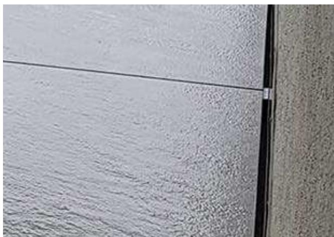
Fig. 35: joint de raccordement supérieur ou égal à 10 mm avec entretoise.
