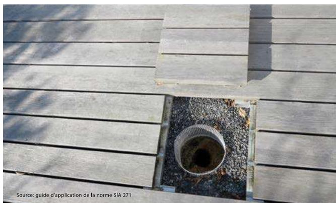
Fig. 43: pour les caillebotis en bois, il n'est pas nécessaire de prévoir une grille d'entrée des eaux de pluie. Il devrait toutefois y avoir une ouverture de service au niveau de l'entrée desdites eaux.
