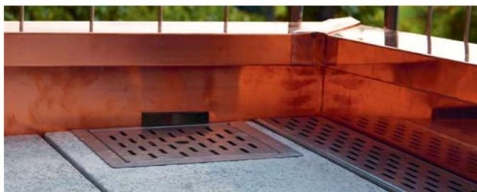
Fig. 32: trop-plein de sécurité avec grille perforée et caniveau de drainage (tiré du guide de la norme SIA 271).
