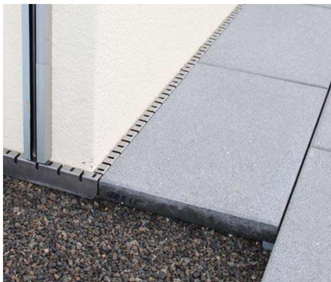
Fig. 33: raccord de bord avec profilé de joint.
