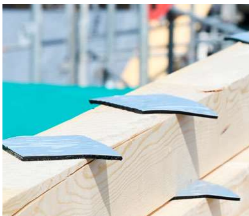
[FIG. 12] Les taquets d'étanchéité sont disposés en forme de losange sous le contre-lattage afin d'optimiser l'écoulement d'eau.
