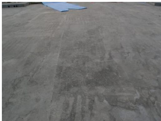
Aspect légèrement brunâtre "vitreux", visible à l'œil nu. Cette couche a dû être enlevée.
