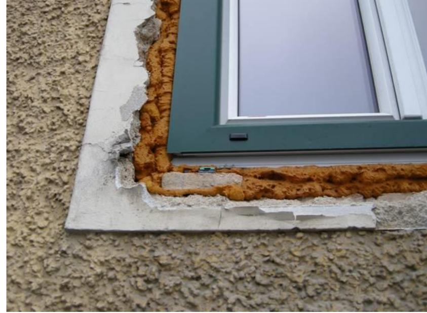
**Exécution correcte (joint adapté), exécution incorrecte (mousse).**
