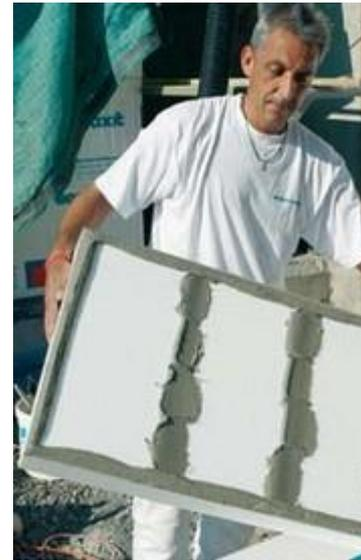
**Dans la pratique: L'encollage doit éviter la convection d'air, suivre les directives de pose des fabricants!**
