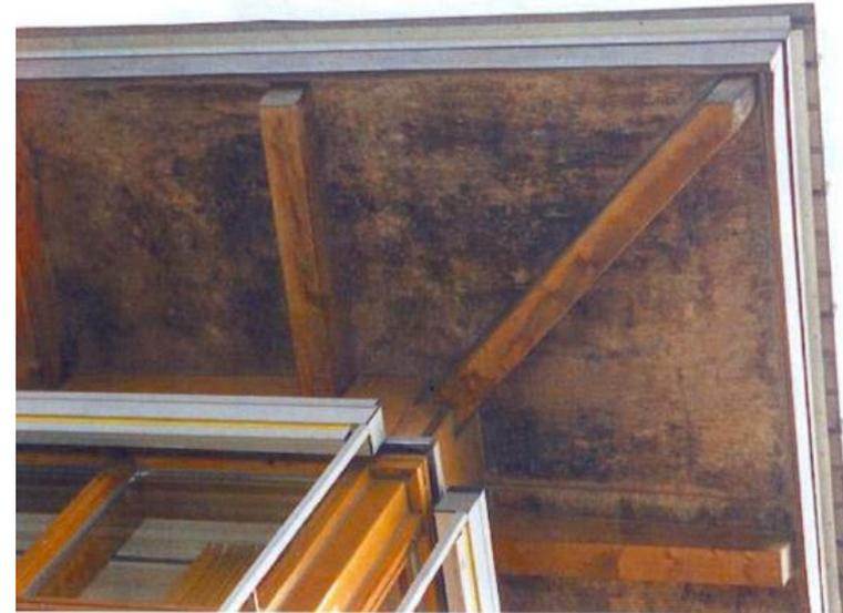
**Dans la pratique: Condensation sous l'avant-toit. Refroidissement au-dessous de la température de l'air extérieur (période nuit), humidité de l'air intérieure par ouverture en un poste des fenêtres.**
